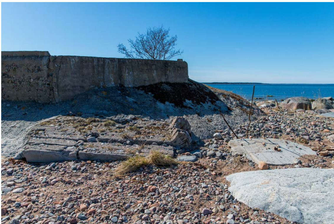
Foto 14 (1112). Lobi TVP. Prožektori alus [3]. On näha, et mere purustusi on varemgi remontida tulnud. Foto Mart Mõniste 24.04.2014.
