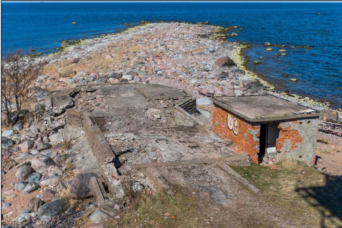
Foto 9 (1122). Lobi TVP. Prožektorialus [3] ei ole neljakandiline, vaid ümardatud nurkadega, kaheksanurkne. Sarnane on ka Pedassaares. Foto Mart Mõniste 24.04.2014.
