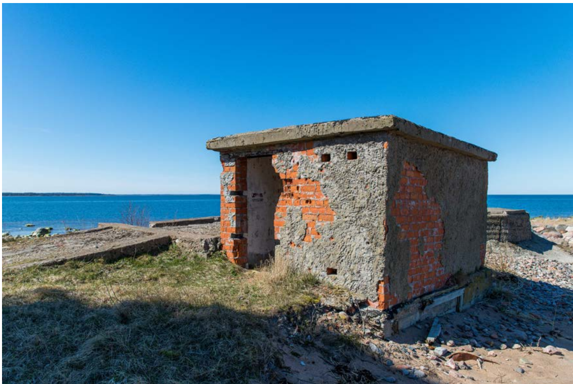
Foto 15 (1113). Lobi TVP. Prožektorialuse kõrval on ilma akendeta putka [4]. Foto Mart Mõniste 24.04.2014.
